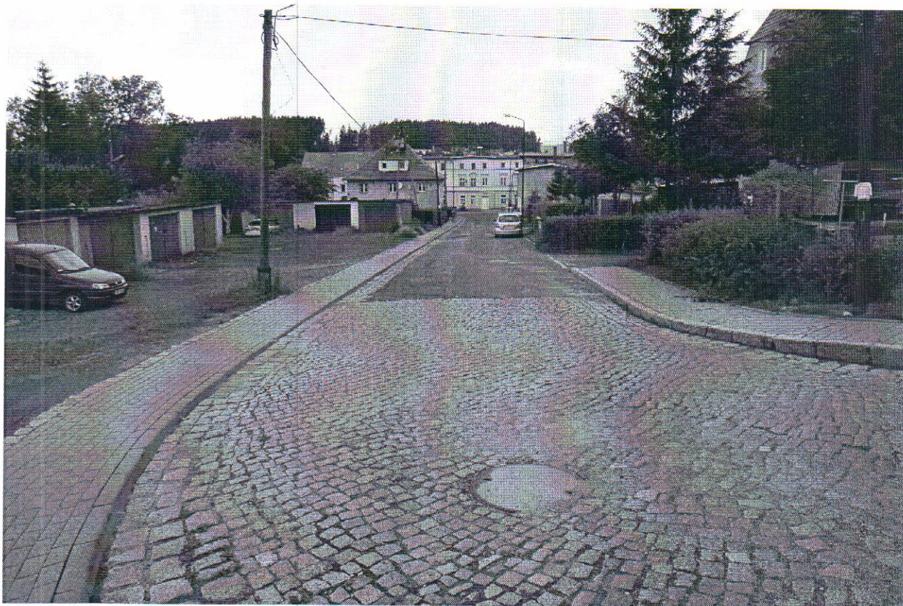
Widok na ul. Kopernika w kierunku ul. Reymonta.
